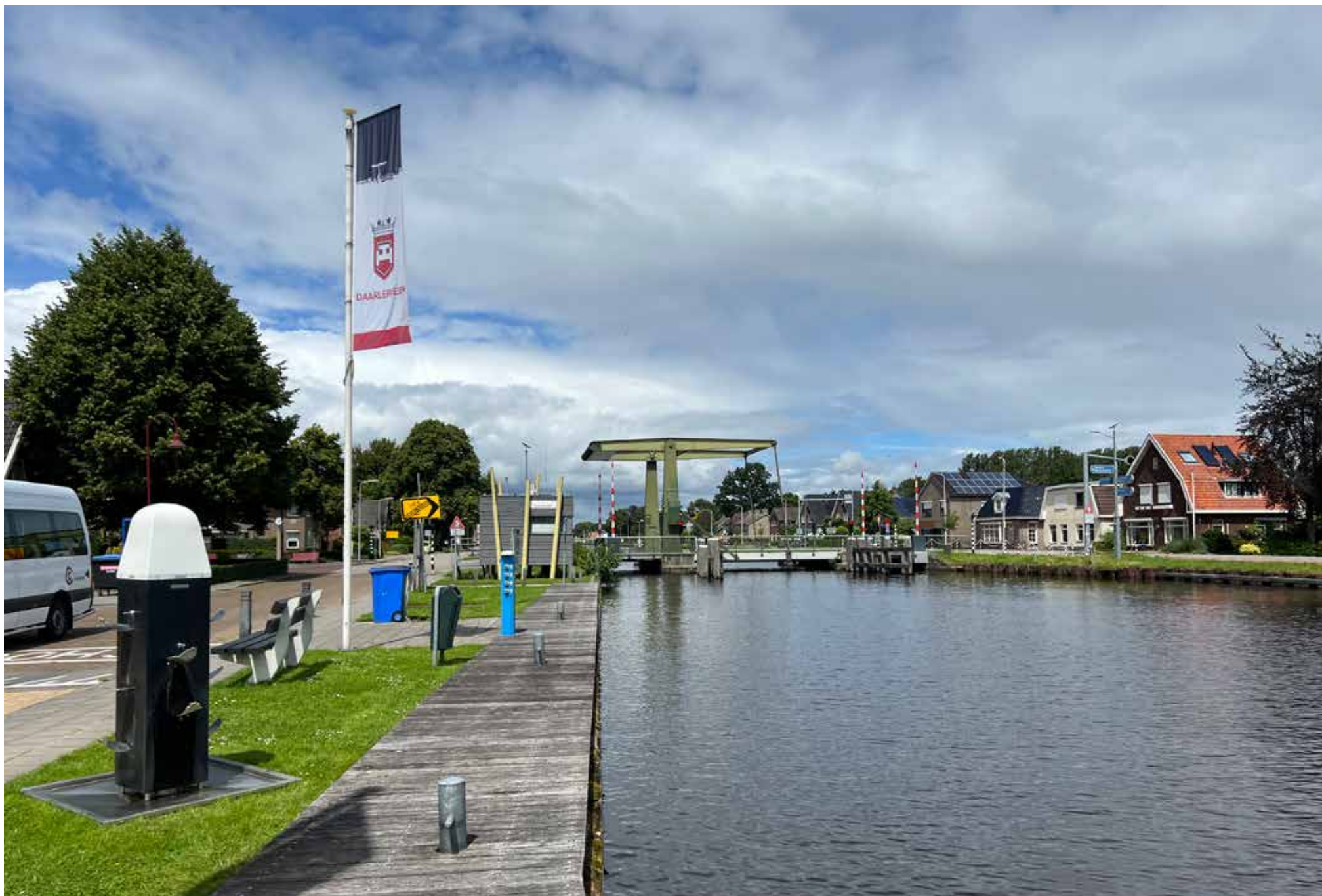
afb. 2. Zicht op brug Daarlerveen.
