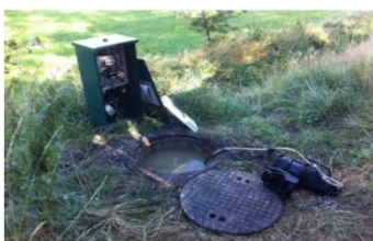
Afbeelding 6.1 drukrioolunit en besturingskast
