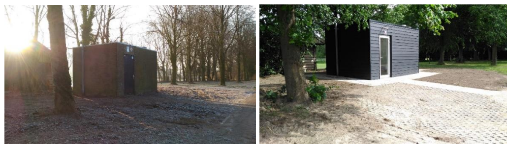
Afbeelding 2.3, gemaal Kerkstraat voor en na de renovatie
